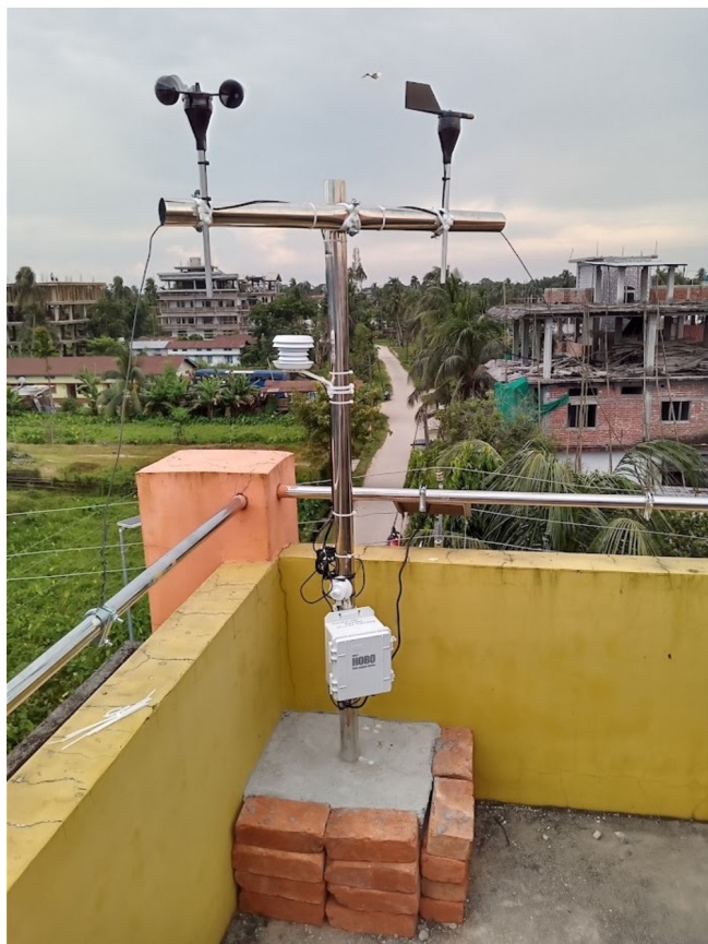
写真 インド・アッサム州の Tihu College に設置した気象観測測器
